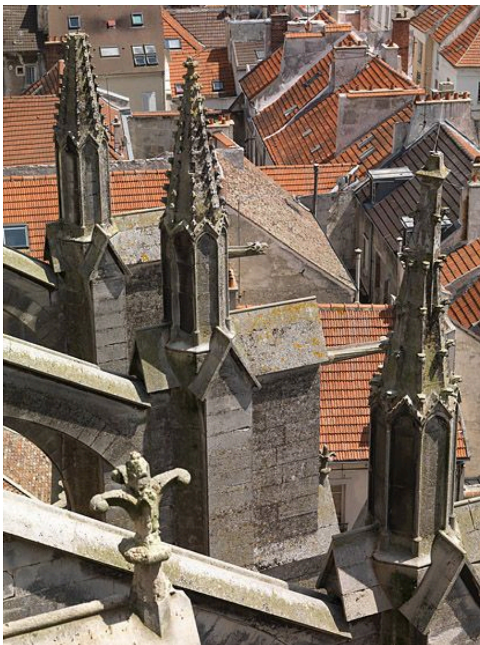
Les arcs-boutants du choeur : détail des pinacles coiffant les culées, côté sud.
