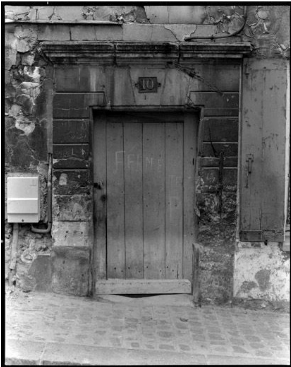
Maison, Sangle (rue de la) 10. La porte d'entrée.
