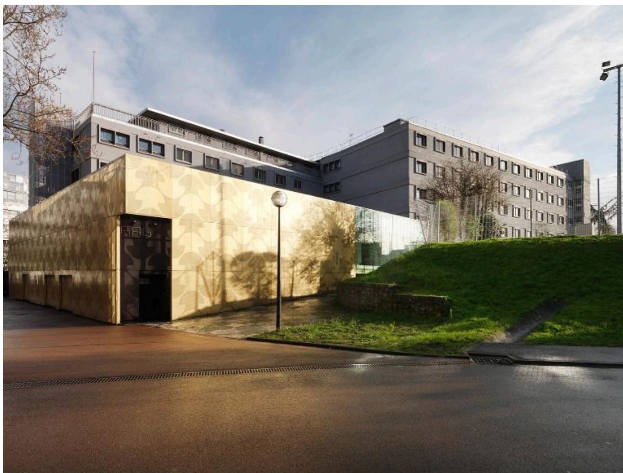
Vue d'ensemble (façade ouest).
