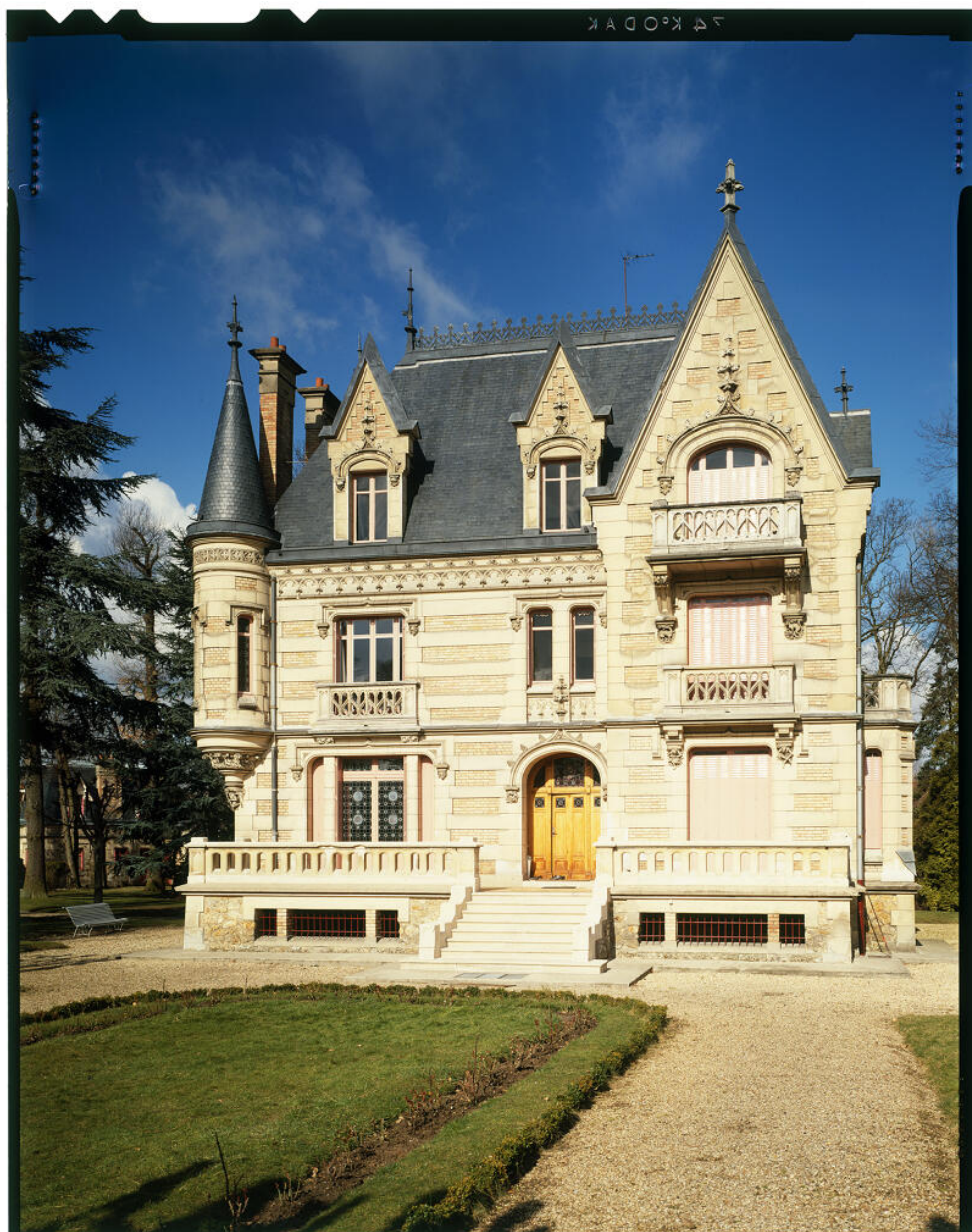
Vue d'ensemble de la façade antérieure.
