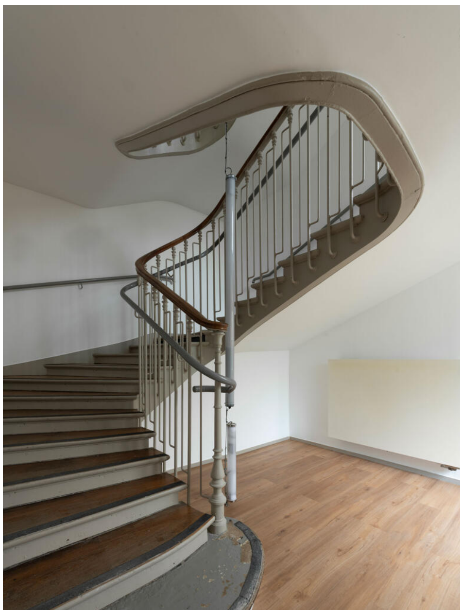
Escalier secondaire, à limon en crémaillère et barreaux en col de cygne, installé au XIXe siècle.
