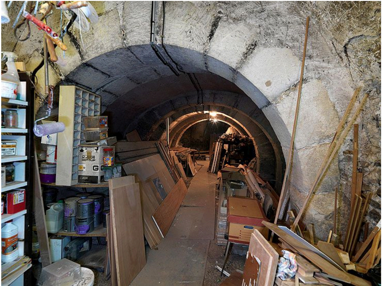
L'entrée de la cave en berceau à arcs doubleaux, qui s'étend sous la chapelle. Vue prise depuis l'ouest.
