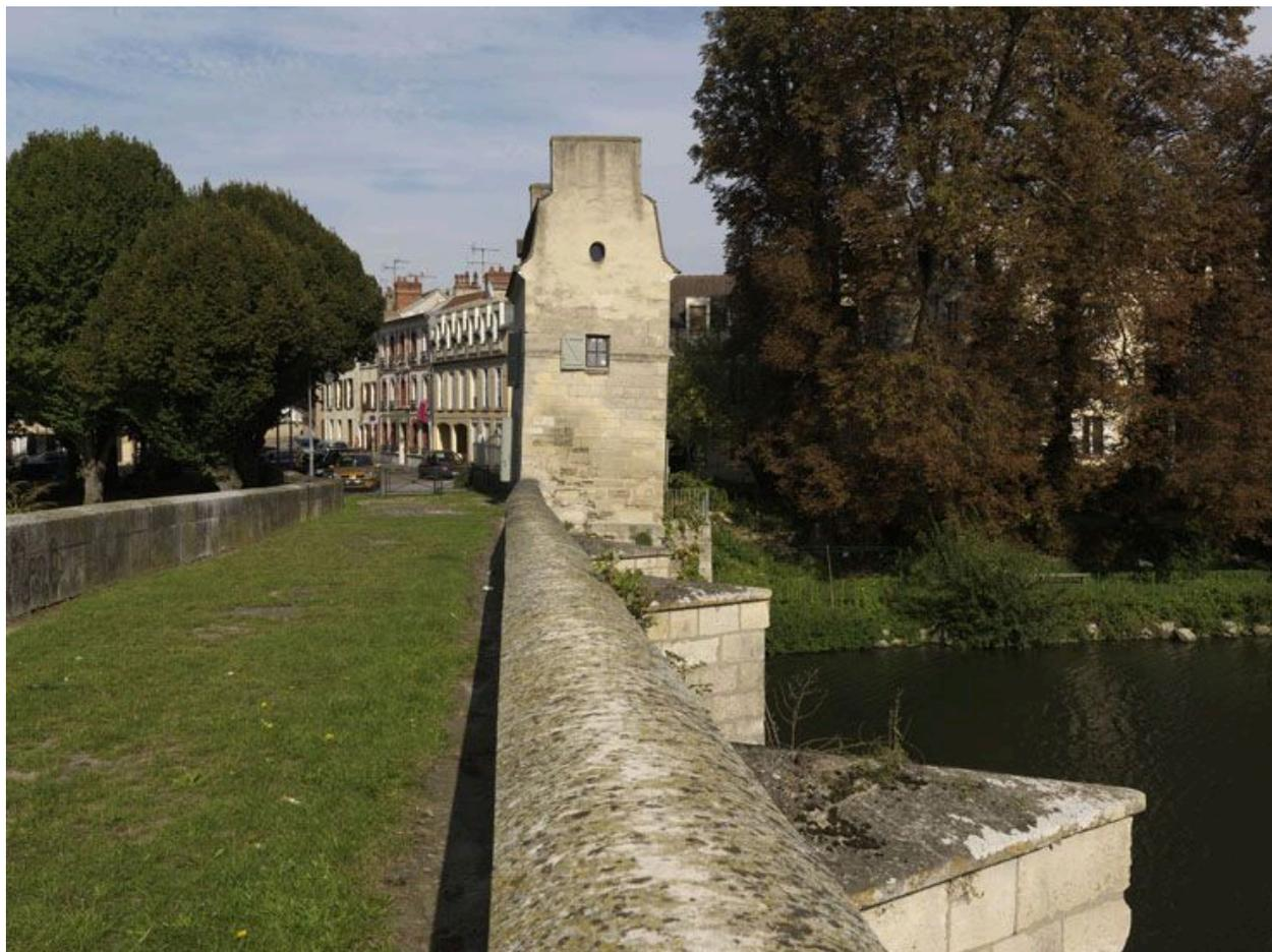
Chaussée du vieux pont de Limay bordée par les parapets. On aperçoit la partie supérieure de deux piles en éperon et la maison du passeur.
