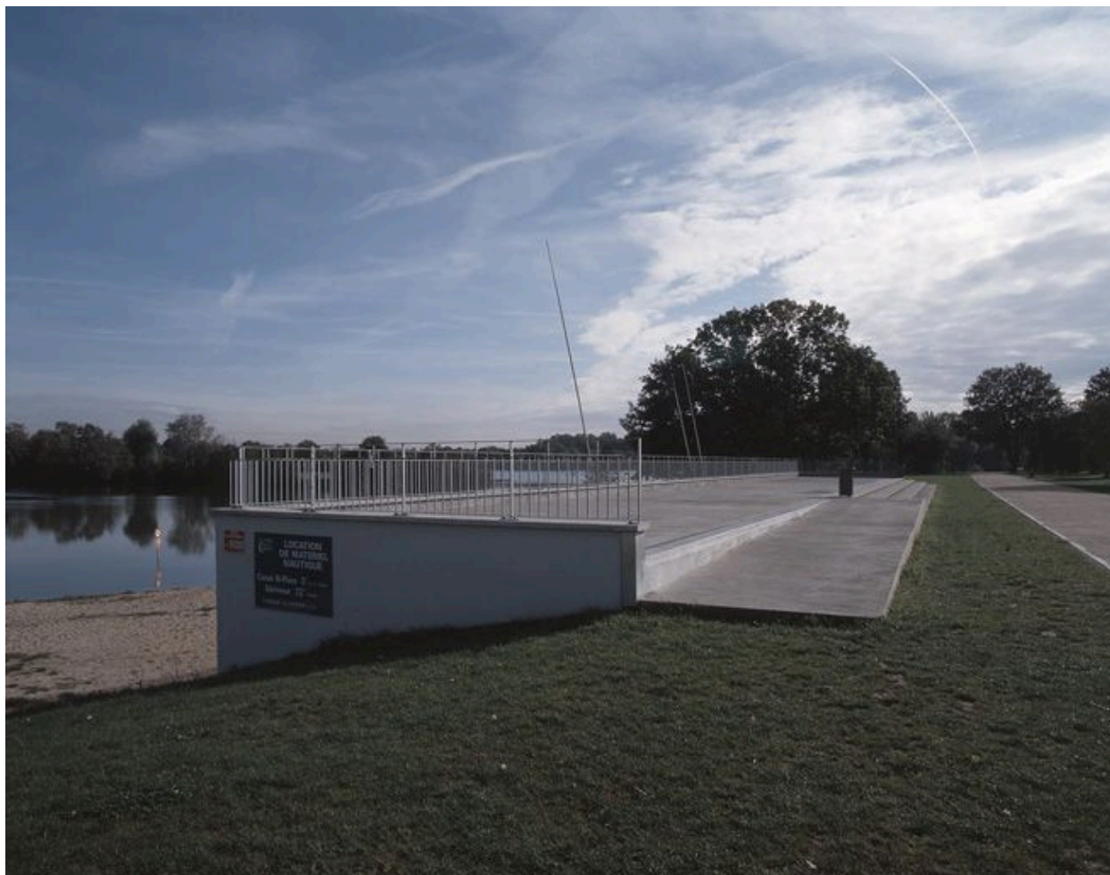
Centre nautique (dériveur canoë) en bordure de l'étang Laveyssière, derrière les bâtiments d'accès au port.
