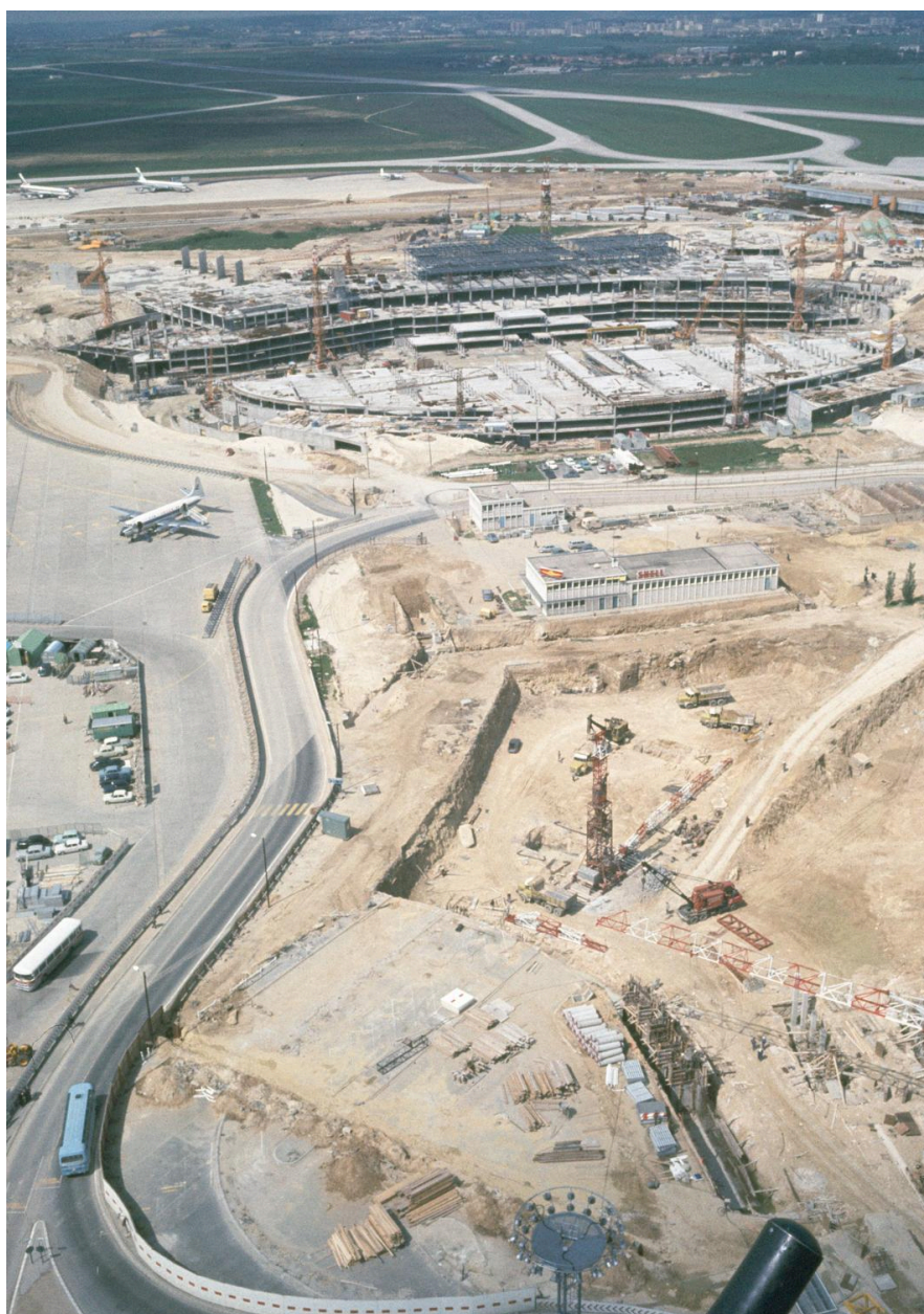
1969, construction d'Orly-Ouest (1968 1971), vue du chantier prise depuis l'est.
