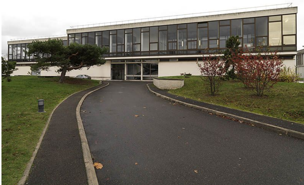
Choisy-le-Roi, établissement des eaux dit usine de traitement des eaux de Choisy. Bâtiment des générateurs d'ozone.
