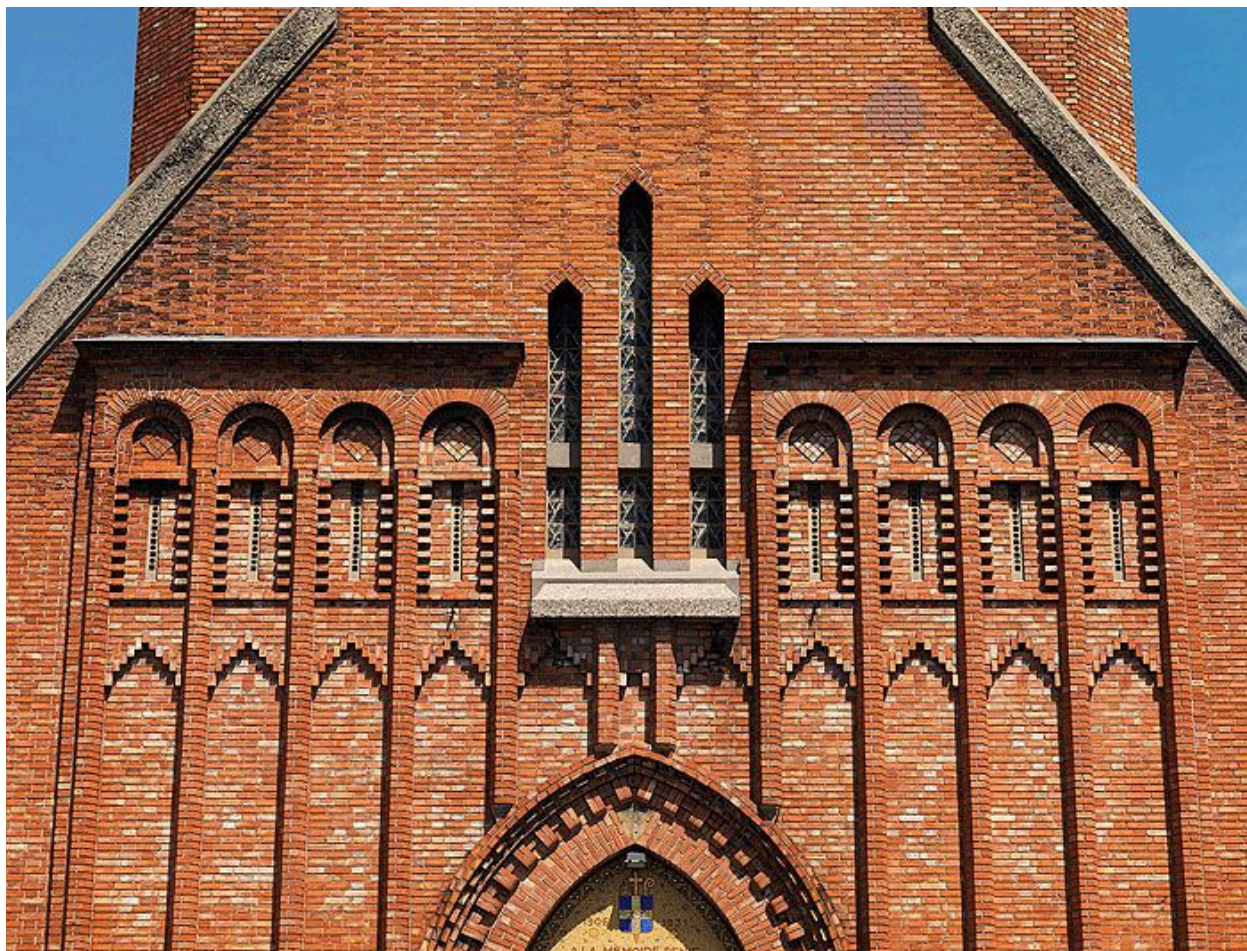
93, Blanc-Mesnil (Le), église paroissiale Saint-Charles, avenue du Capitaine-René-Fonck . Décor du registre supérieur de la façade.
