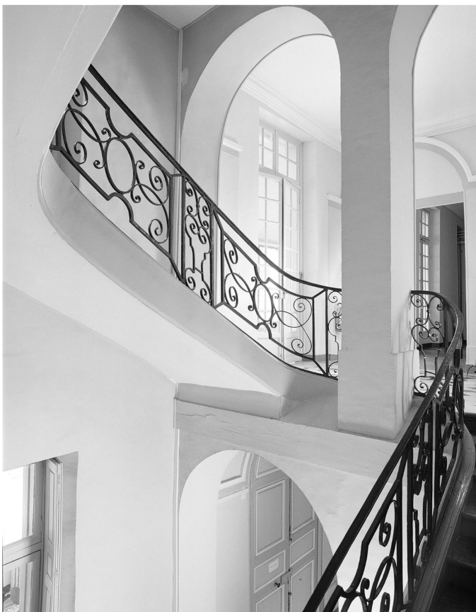
La cage d'escalier entre le rez-de-chaussée et le 1er étage.
