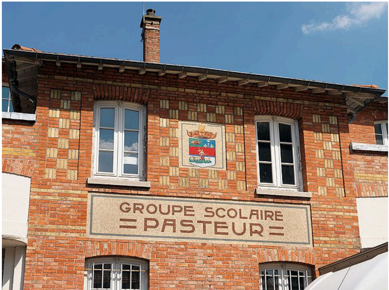
92, Gennevilliers, école primaire dite groupe scolaire Pasteur, 60 rue Richelieu. Détail de l'appareil en damier polychrome de la façade antérieure de briques.
