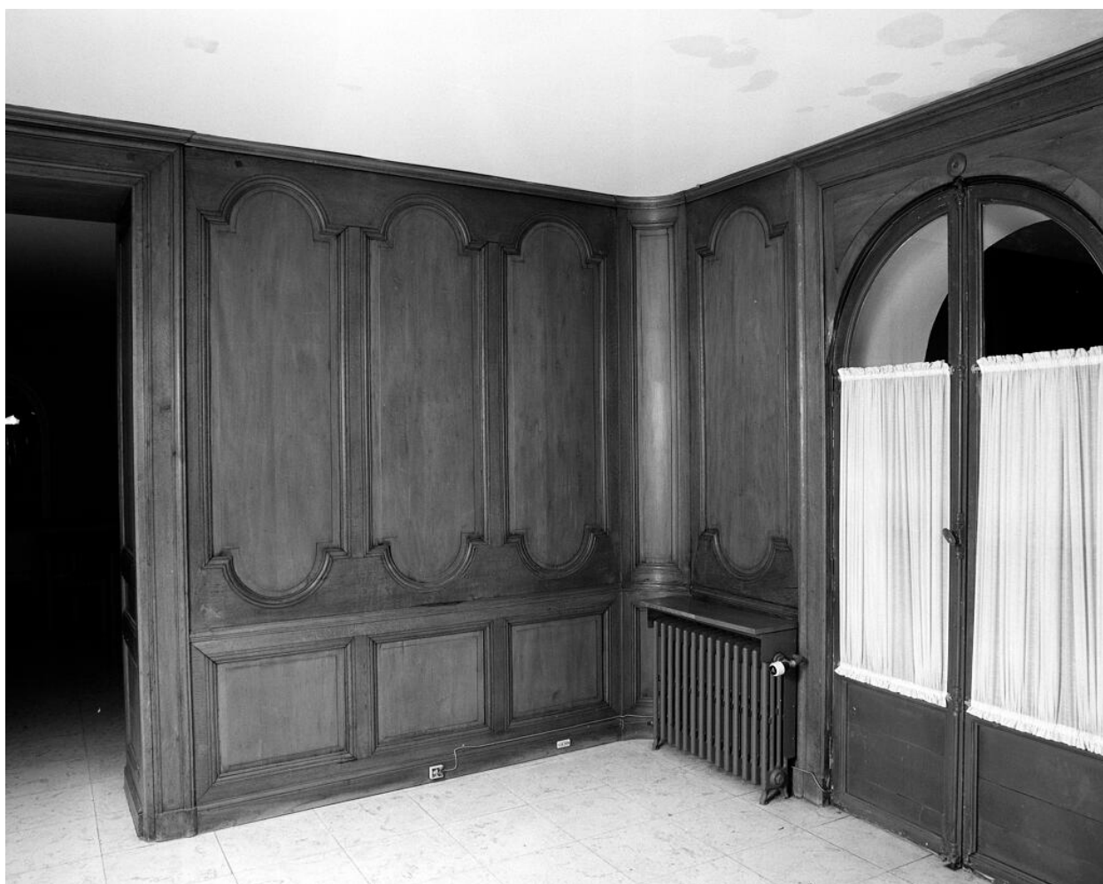
Lambris de chêne de la salle à manger au rez-de-chaussée.
