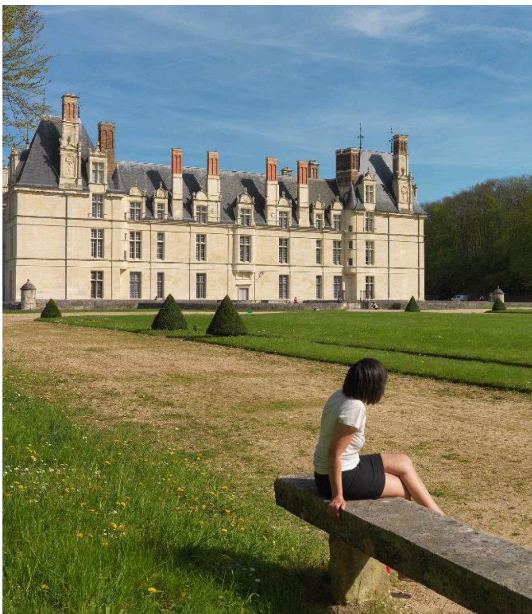
La façade occidentale du château, vue depuis le parterre.
