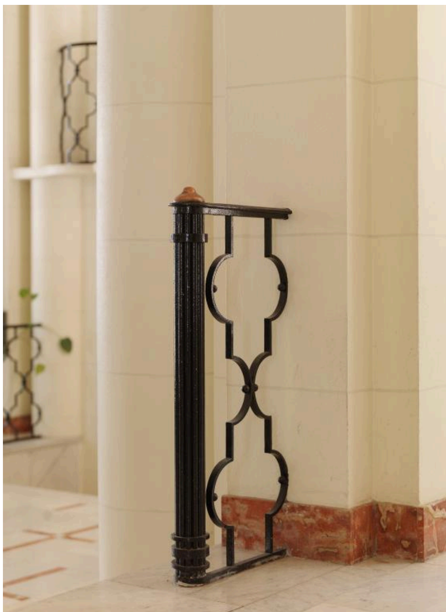
Détail des ferronneries du hall d'entrée.
