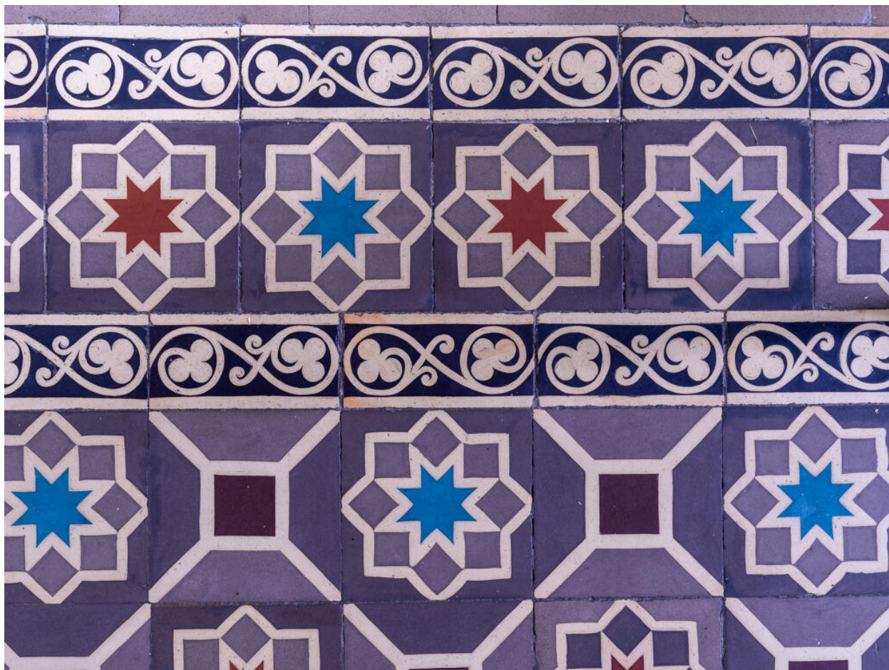
Vue de détail de carreaux de ciment composant le sol du couloir nord du rez-de-chaussée.
