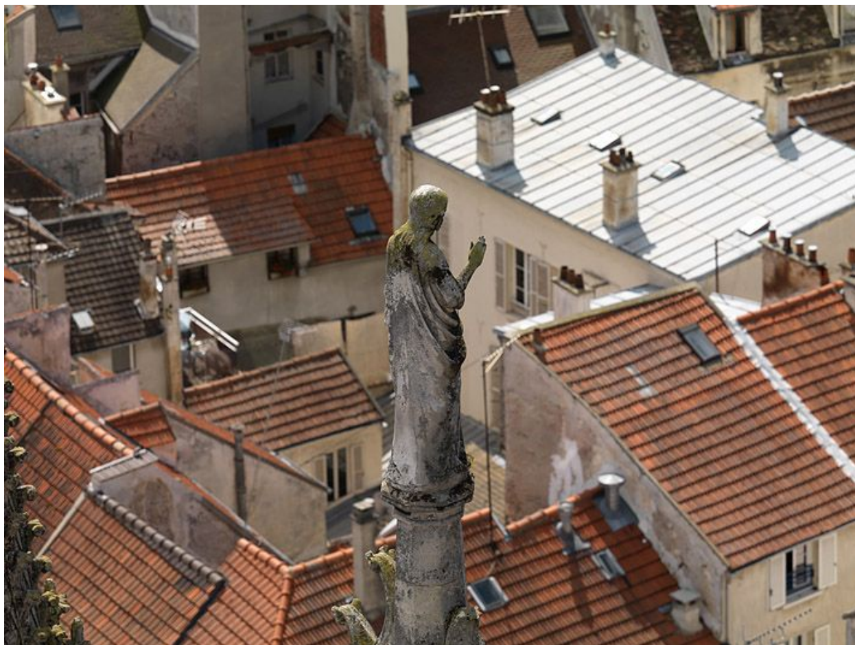
La statue du pignon sud du transept, dominant les toits du quartier.
