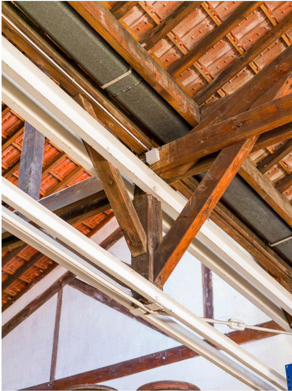
Bâtiment aux trois sheds. Détail de la charpente autoporteuse métallique datant vraisemblablement du début du XXe siècle.
