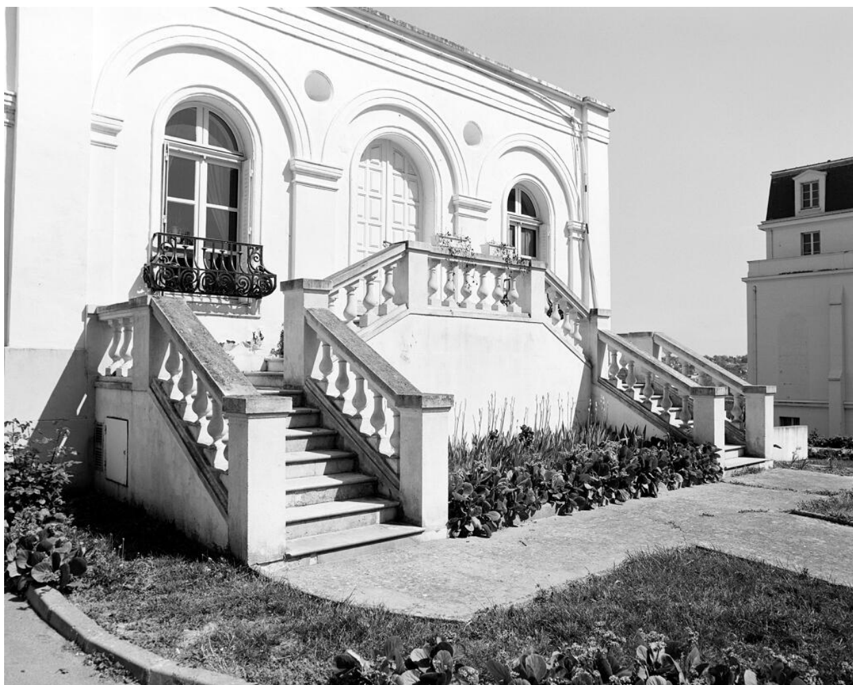
La façade antérieure de l'orangerie : détail de l'escalier.
