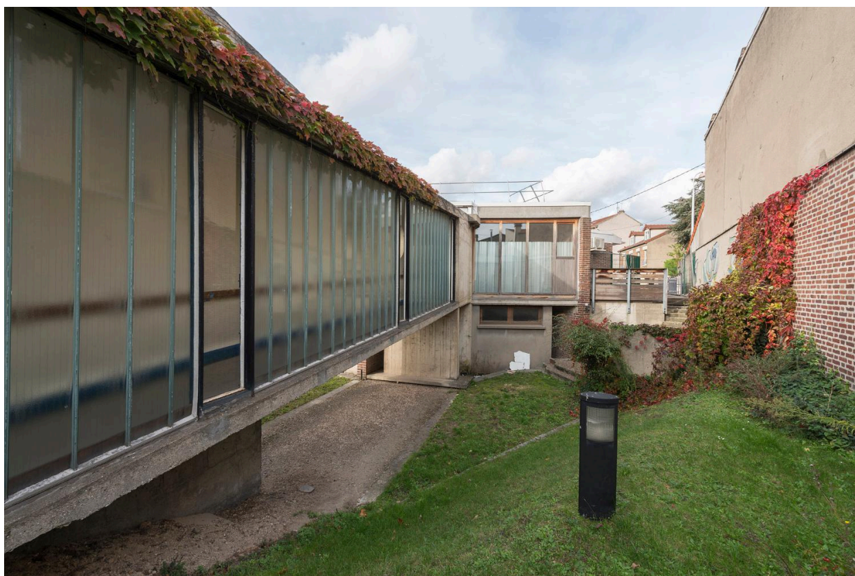
Vue de la rampe sud-est, en direction du pavillon d'accueil.
