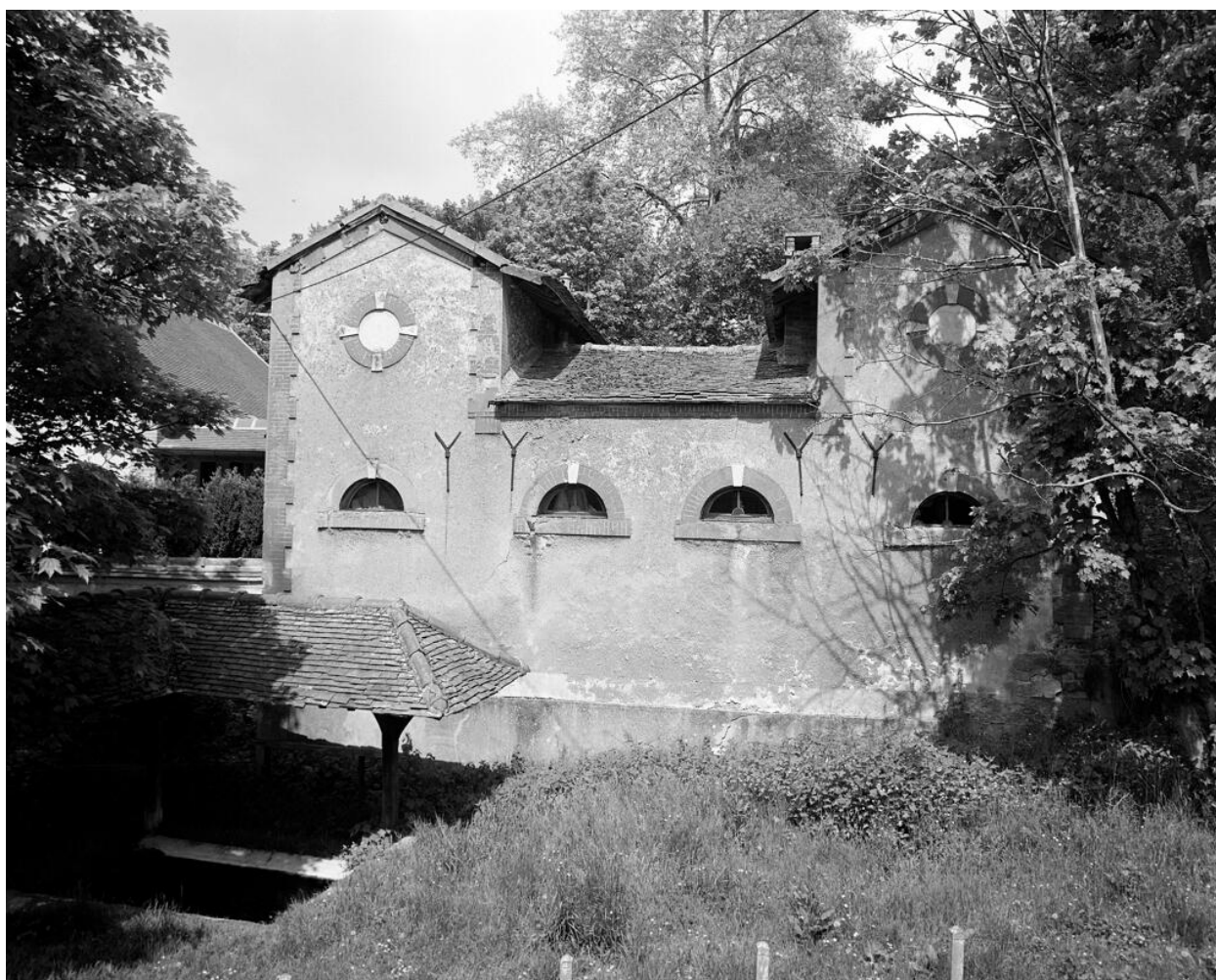
Façade postérieure de la bergerie.
