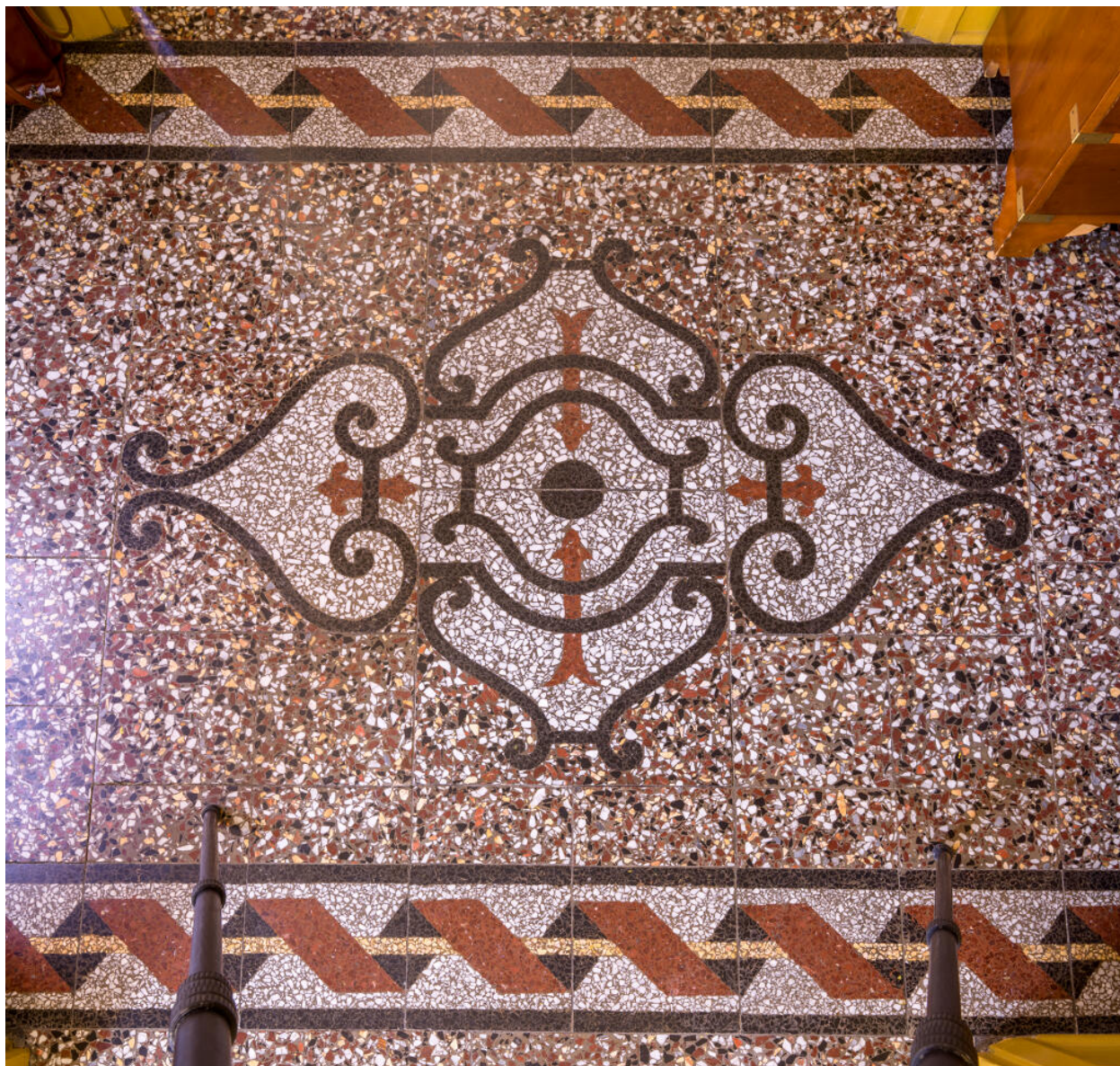
Carreaux de terrazzo du vestibule.
