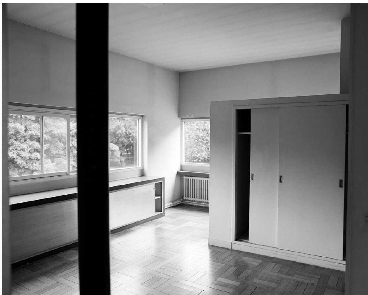
Vue intérieure d'une chambre au premier étage : les portes des placards sous les baies sont en métal.
