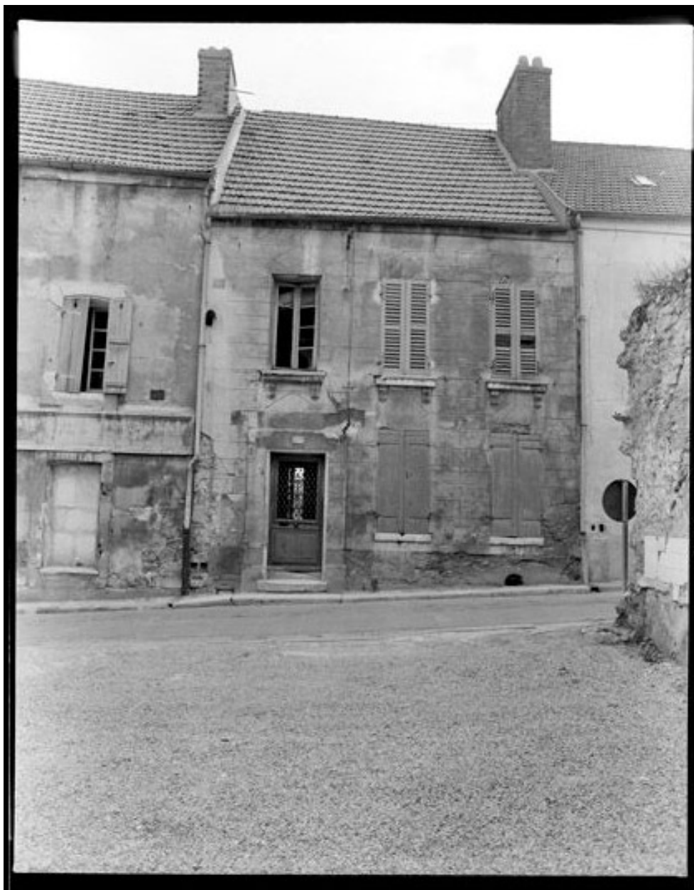
Maison, Tanneries (rue des) 4. Façade sur rue.
