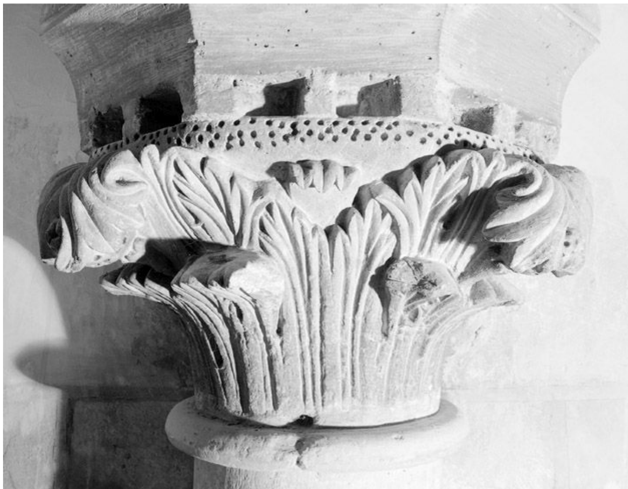
Chapiteau à feuille d'acanthé (vaisseau central de la nef, 1ère travée, côté sud), vu depuis un échafaudage en 2005.
