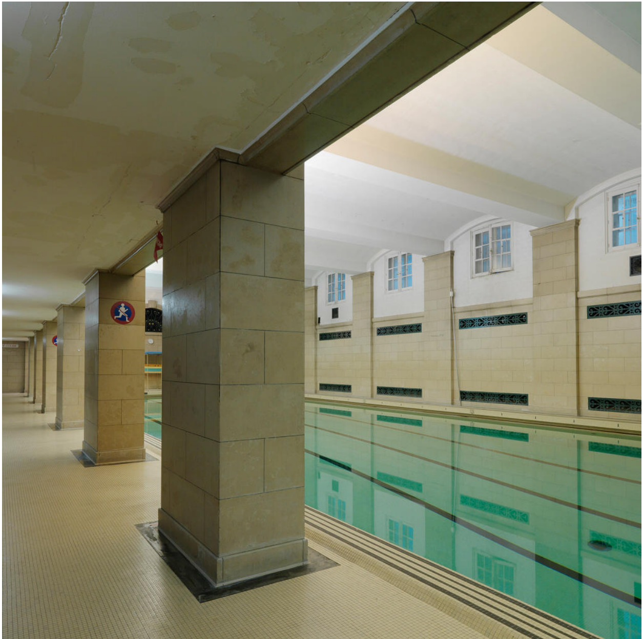
Coursive desservant le bassin. Piscine de la Cité internationale universitaire de Paris et salle de boxe, actuellement salle de musculation
