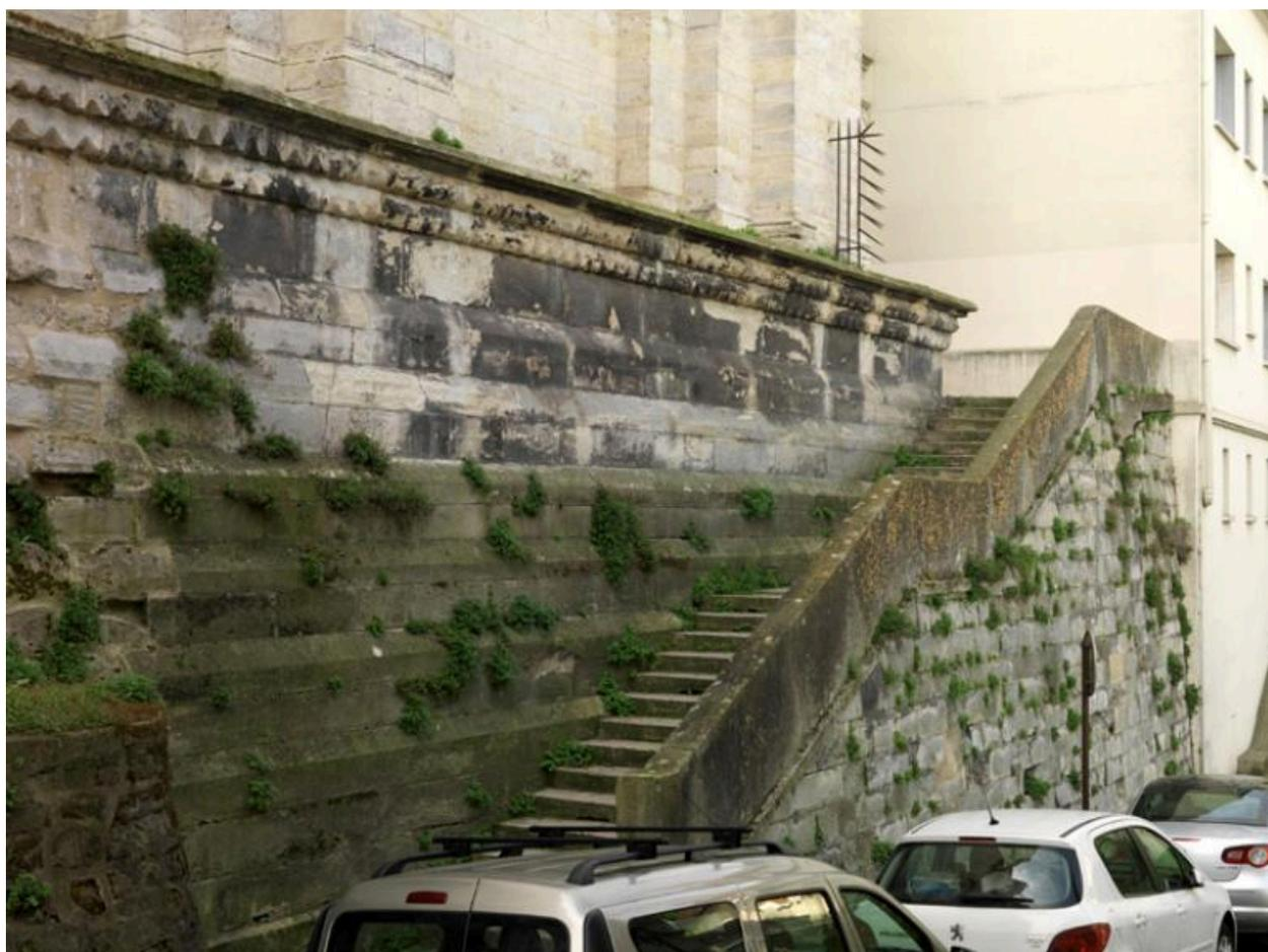
Plate forme destinée à racheter la déclivité du sol. C'est par là qu'a commencé la construction de la collégiale.
