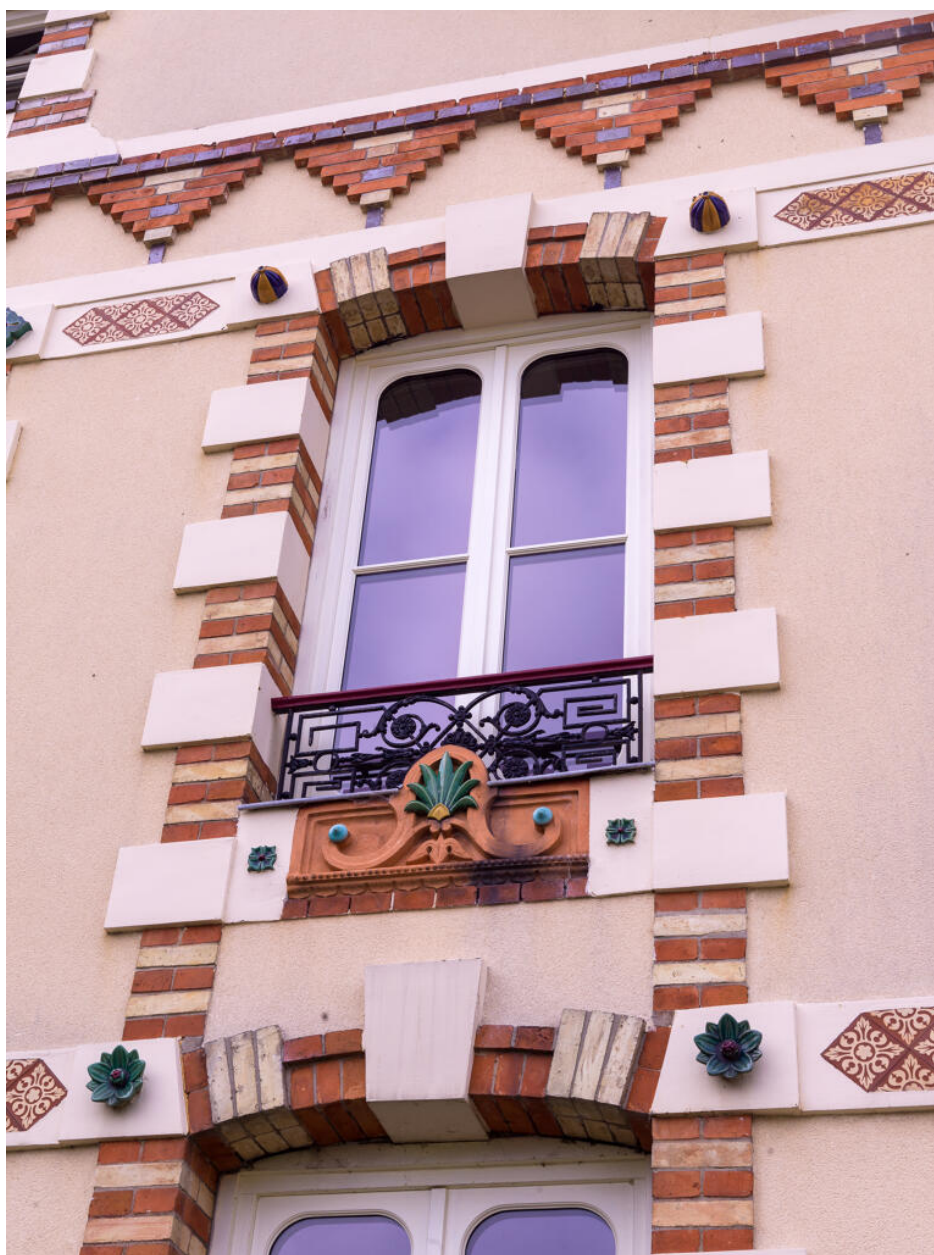
Vue de la façade nord, détail d'une fenêtre de l'étage.
