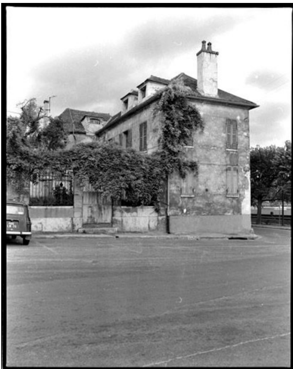
Hôtel particulier, Hèvre (place de) 2. Façade sur la place de la Heuse.
