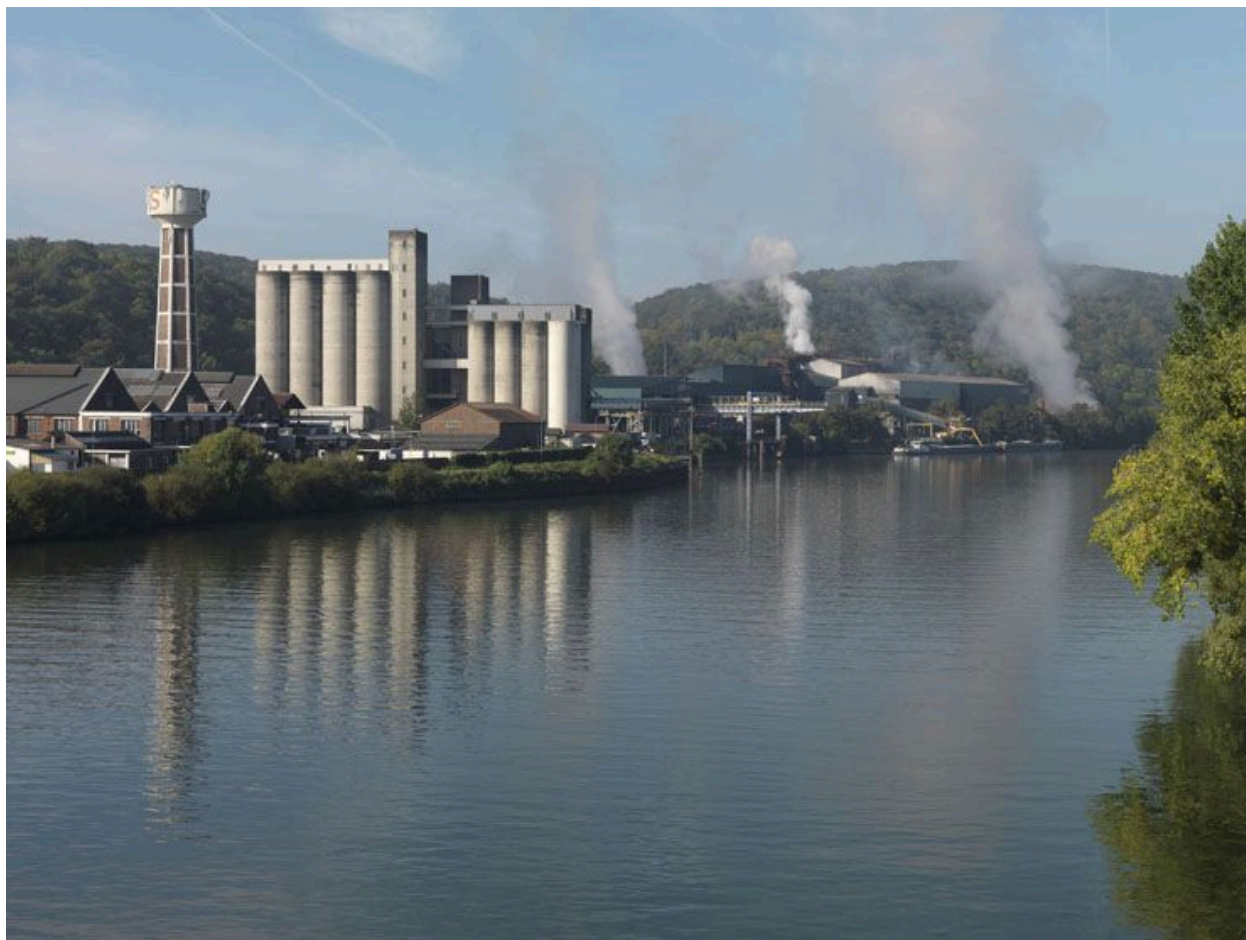
Bonnières-sur-Seine : vue depuis le pont vers l'aval. Les silos et le château d'eau.
