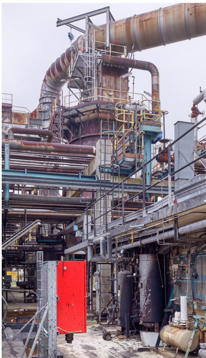
Unités Est - Zone FCC (Unité 651). Vue du four de l'alkylation situé sur la zone viscoréducteur.
