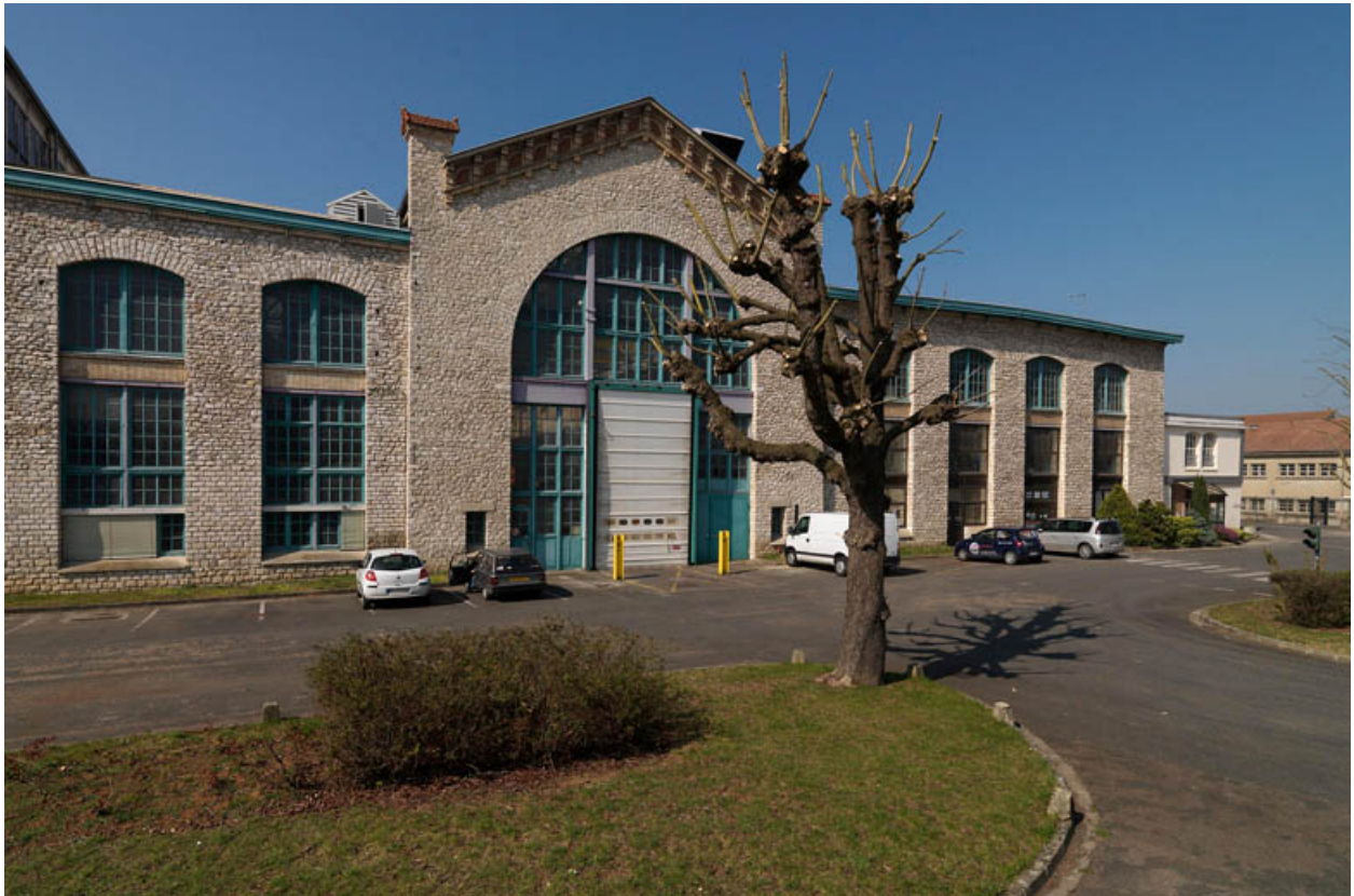
Façade de la liason longitudinale nord.
