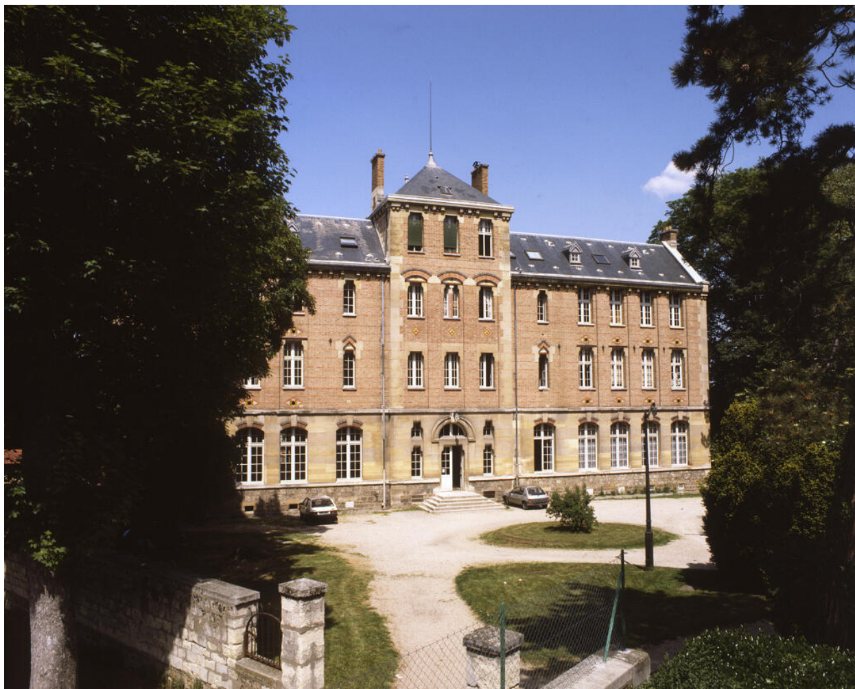
L'infirmerie. Façade sur le parc (sud).
