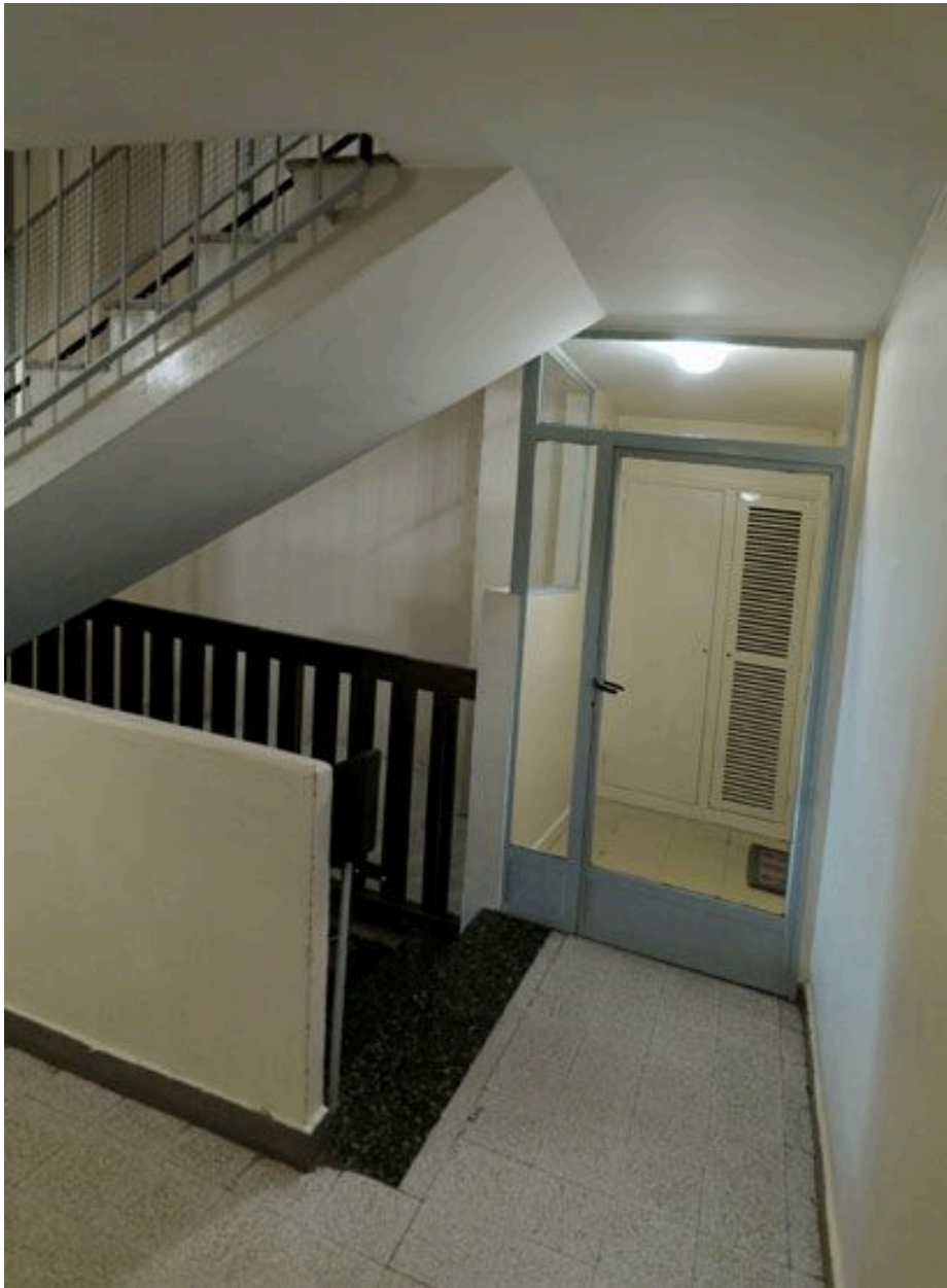
Palier de la tour N.
