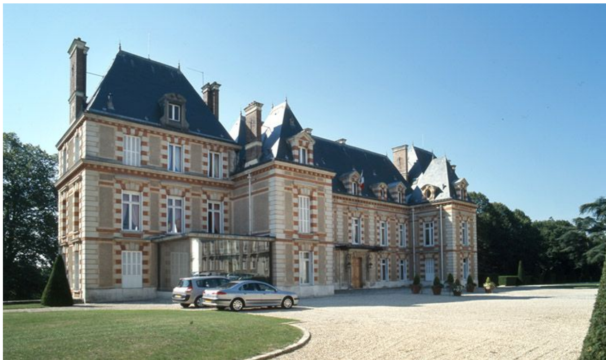
La façade sur cour (élévation nord), vue depuis le nord-est.
