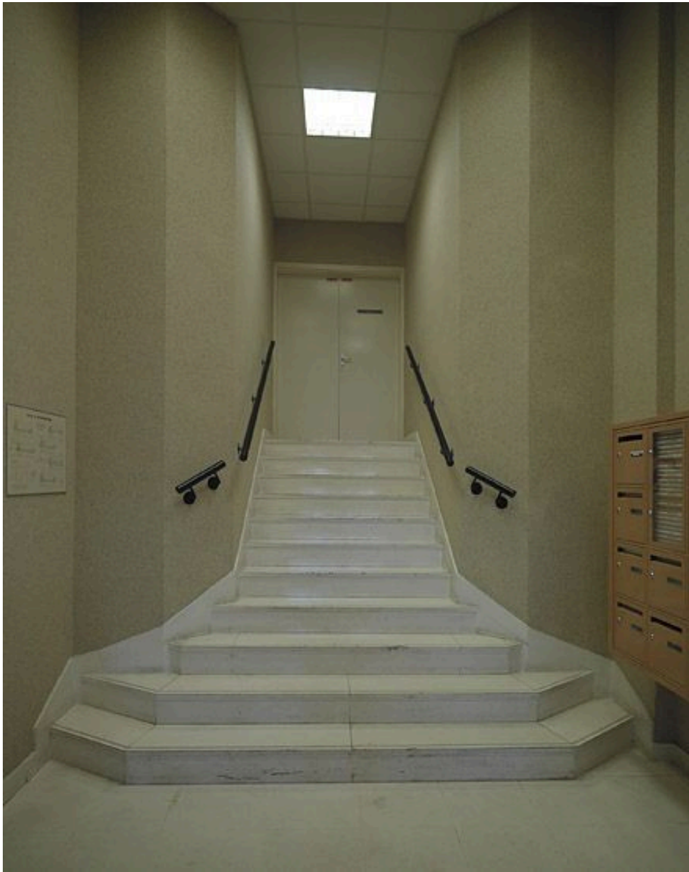
Escalier d'accès a l'extension PIC.
