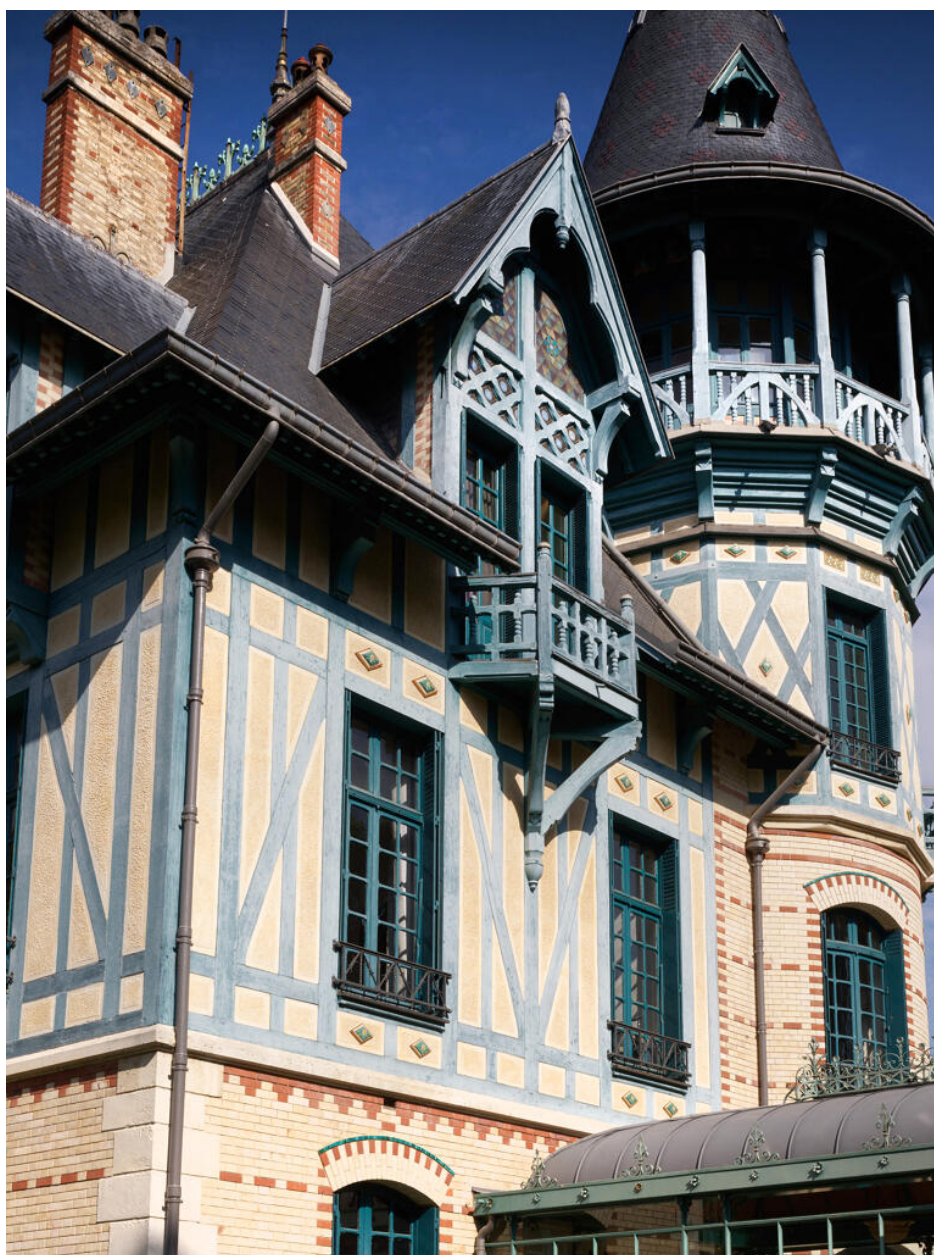
Partie haute de la façade est.
