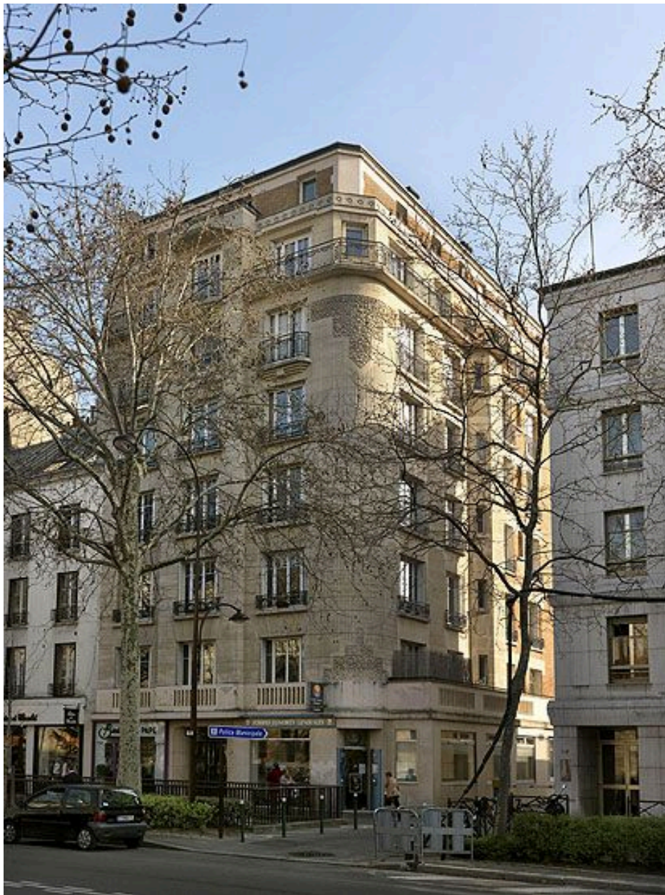
92, Neuilly-sur-Seine, immeuble, 115 avenue Achille-Peretti. Elévation de l'immeuble de pierre avec étage de surcroît de brique.
