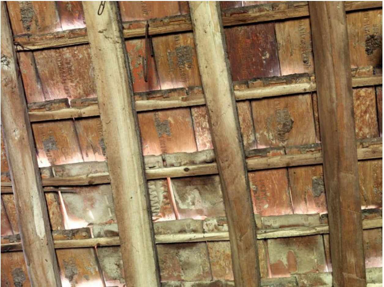
Détail de la couverture de l'atelier.
