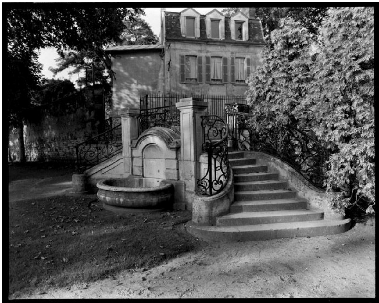
Vue de l'escalier extérieur.
