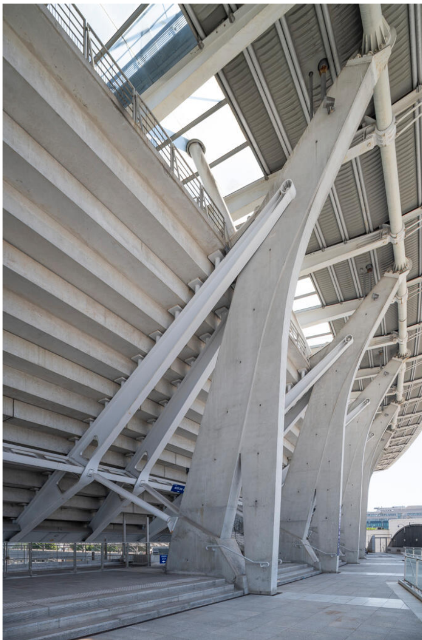
Stade Charléty. Pilier de soutien des tribunes et couvertures.
