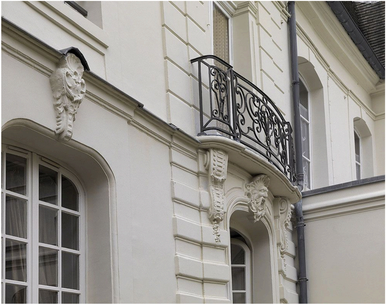
Détail de la travée "noble" de l'aile sud, avec son balcon en fer forgé : vue de côté.
