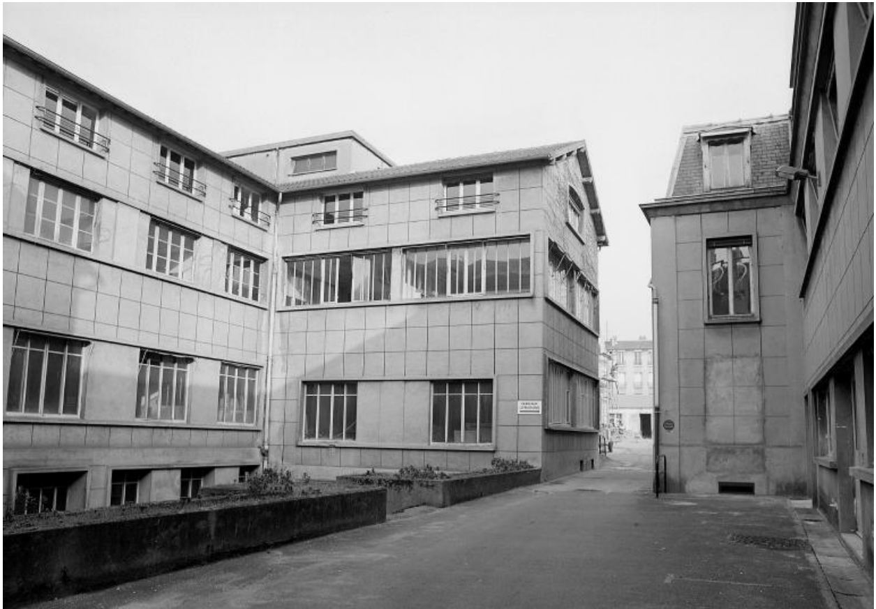
Vue des ateliers sur cour. Photographie. (AD Seine-Saint-Denis. A NB 118)
