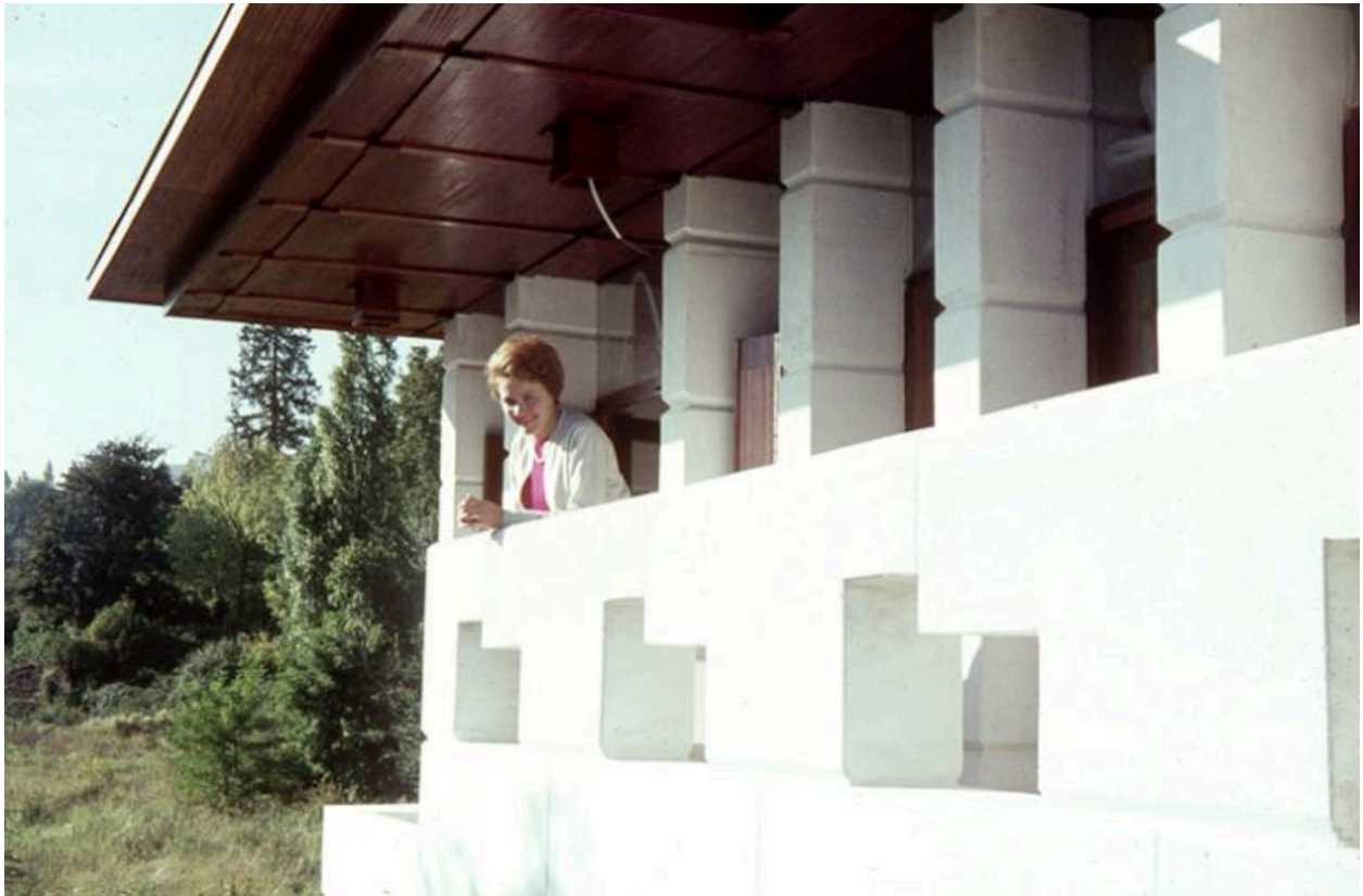
Vue ancienne de la terrasse et de l'avancée du toit.
