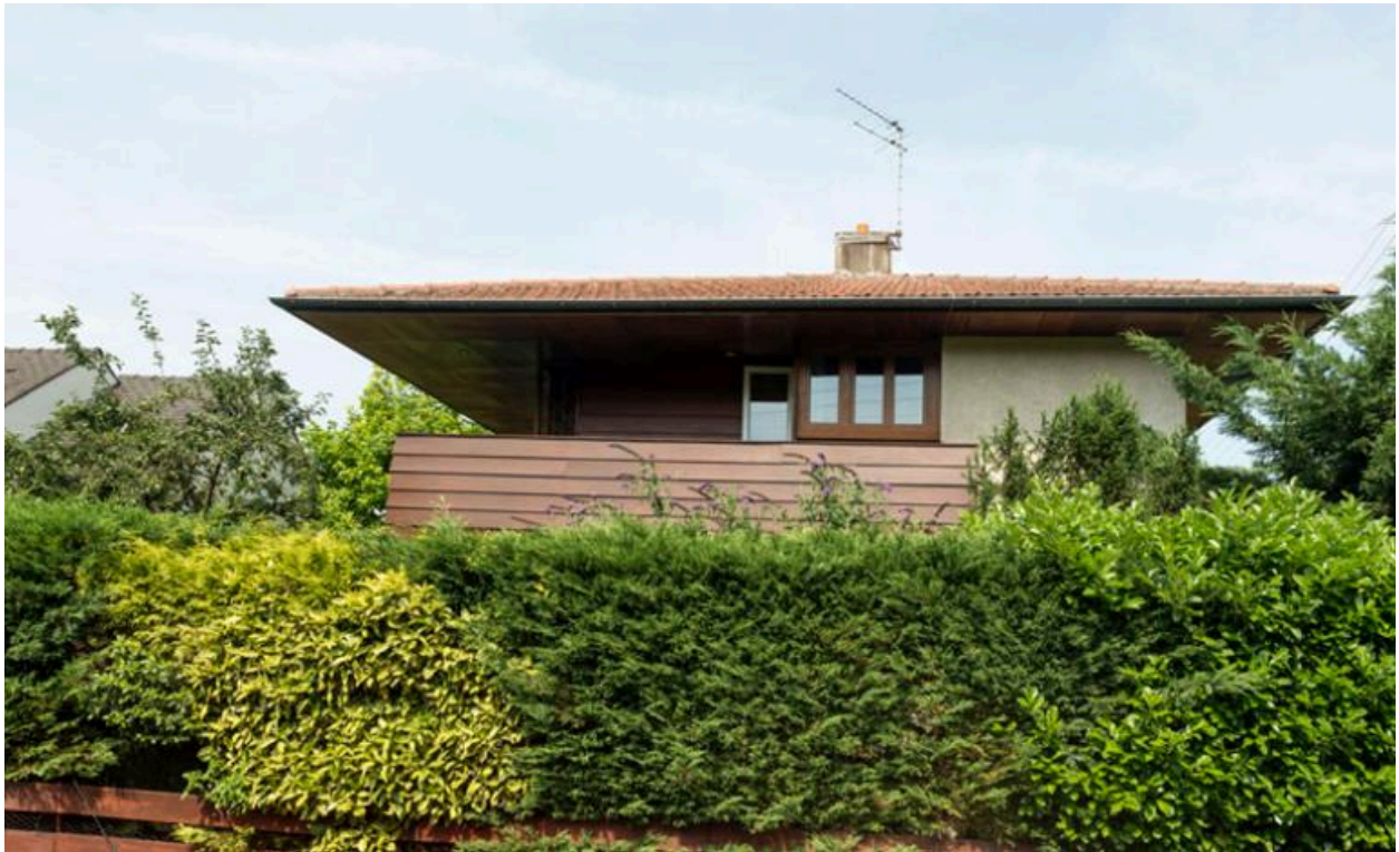
Vue générale de la façade latérale gauche.
