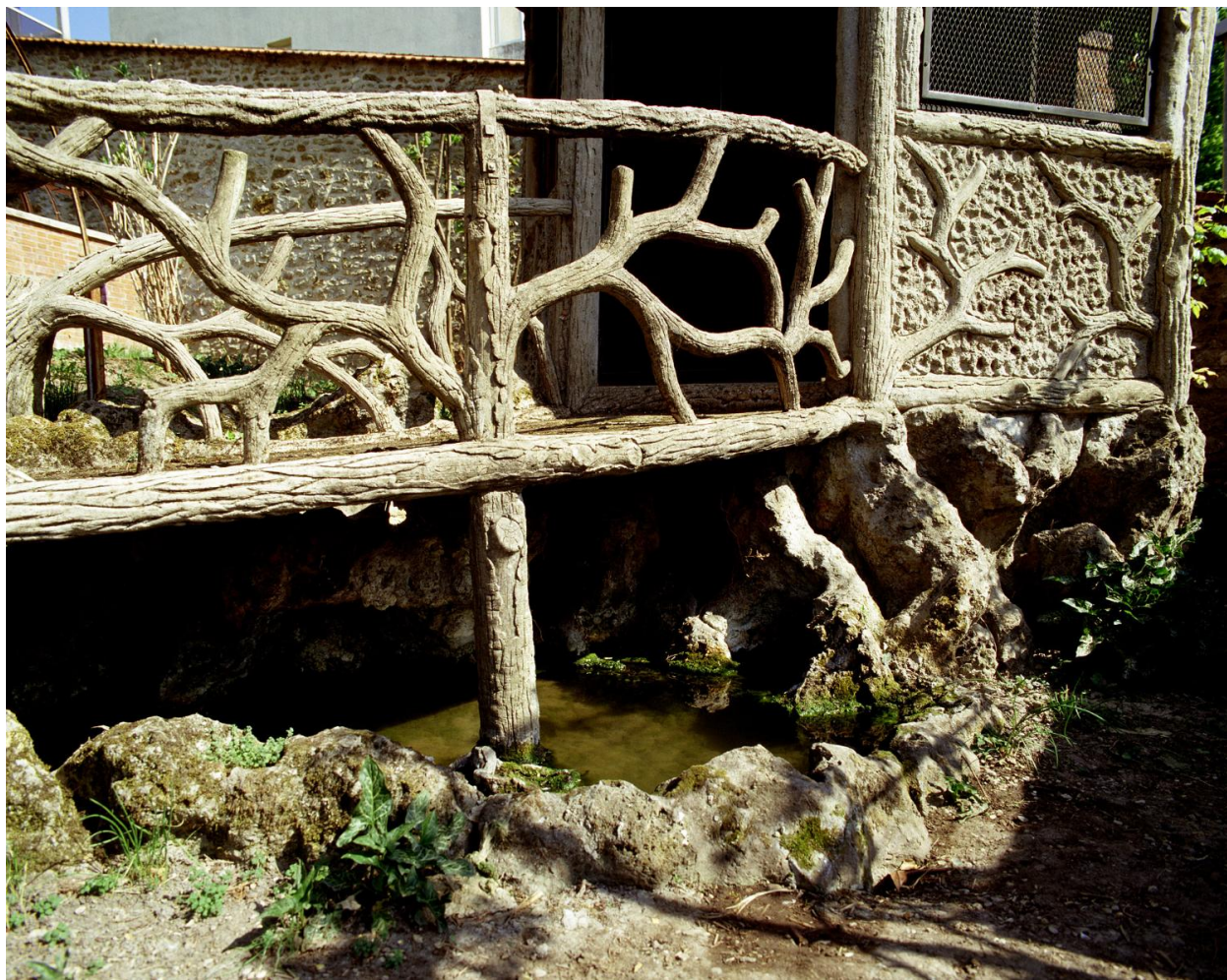
Détail de la balustrade du chemin d'accès au kiosque.
