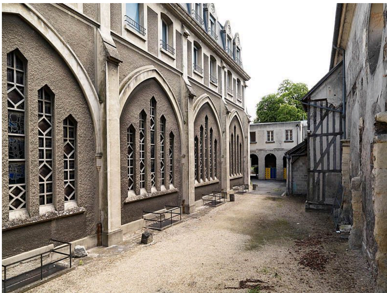
Baies du côté sud de la nouvelle chapelle.
