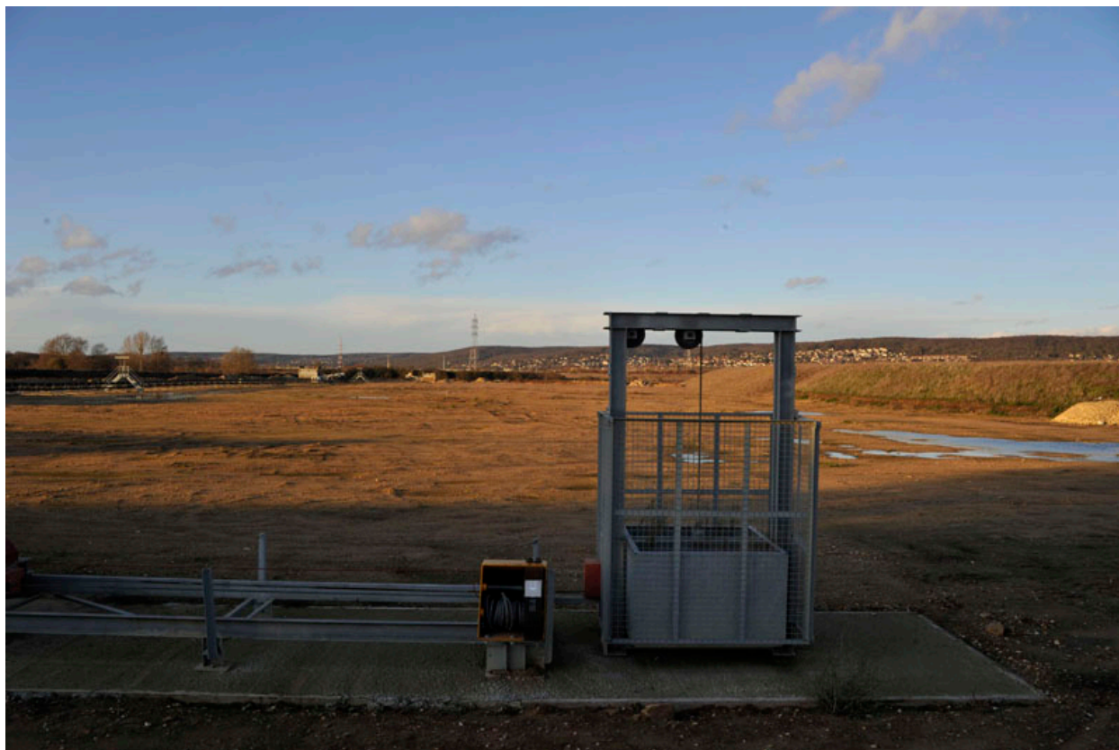
Triel-sur-Seine, carrière (sablère et gravière) Lafarge Granulats, 2 chemin des Graviers. Vue générale.
