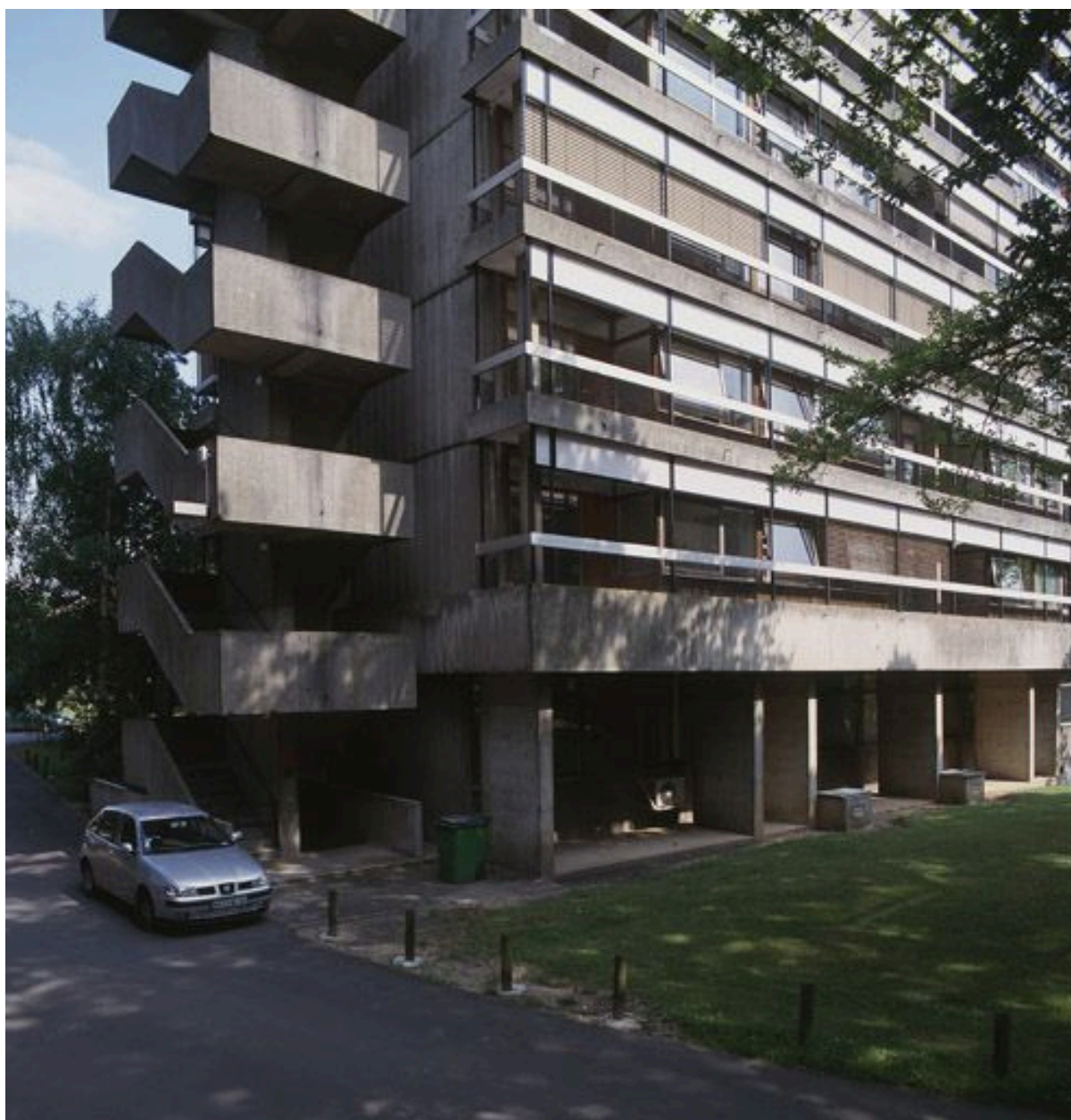
Détail de l'escalier extérieur de l'hôpital Georges-Brassens.
